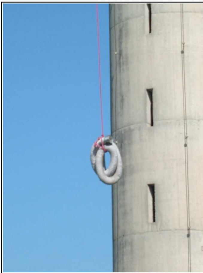
Figura 20 – Içamento do tubo do insuflador de ar. Fonte: Foto do autor.
