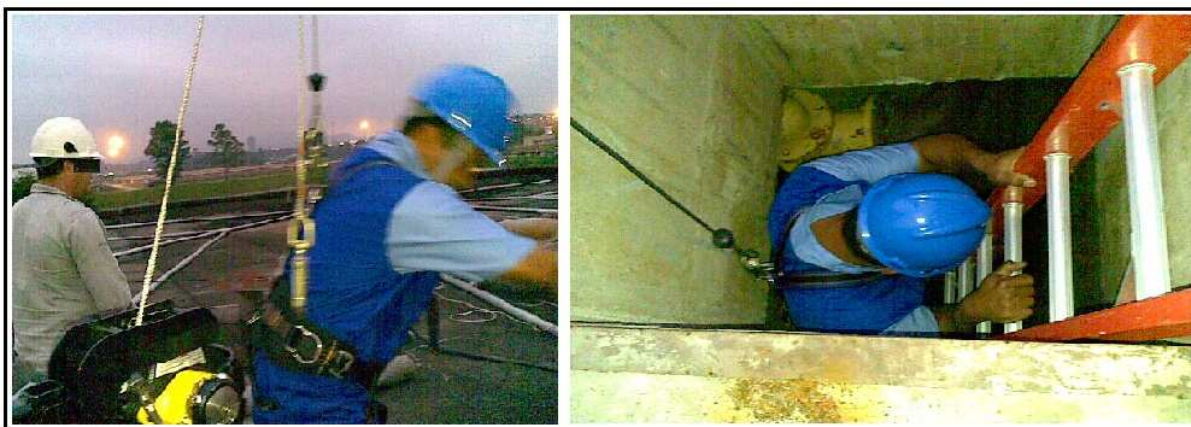
Figura 24 – Entrada do funcionário no espaço confinado. Fonte: Fotos do autor.
